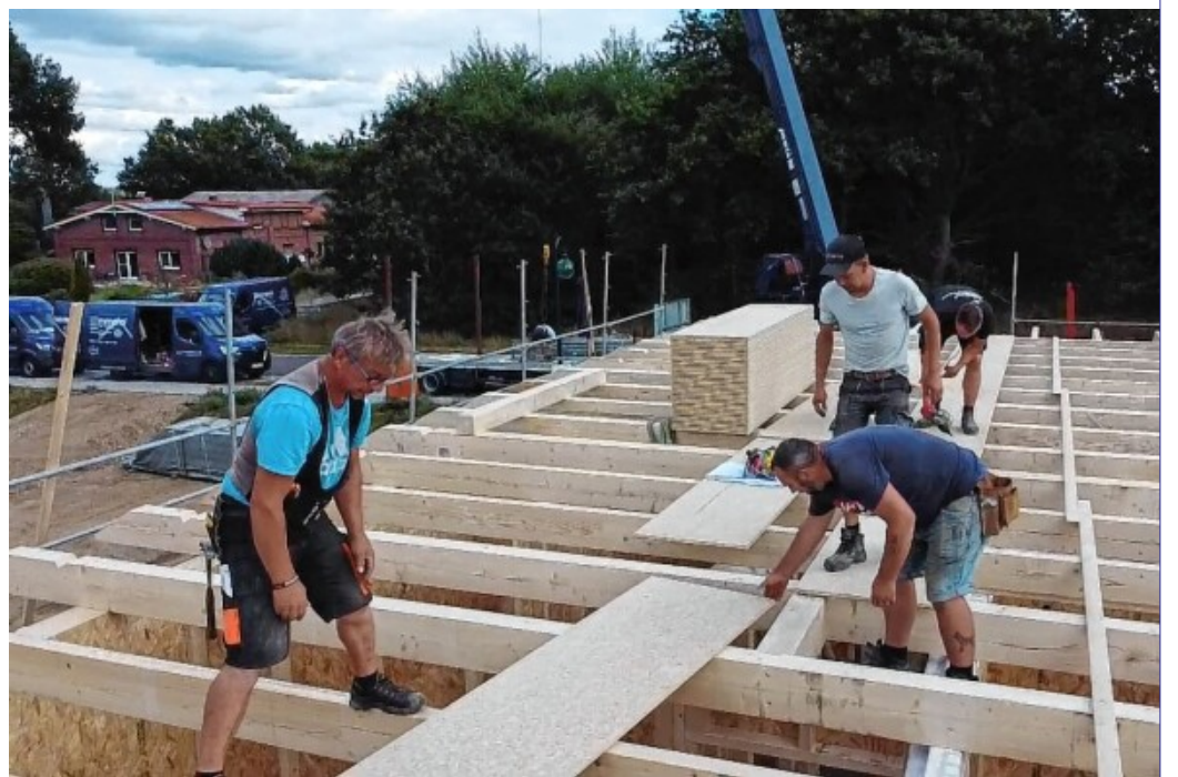
Die Mitarbeiter legen größten Wert auf die fachgerechte Ausführung der Arbeiten.
