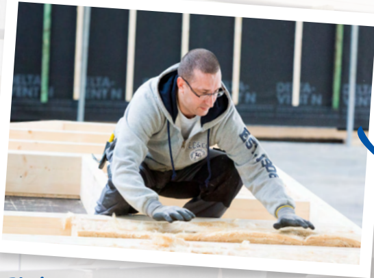
Einbringung der Dämmung.
