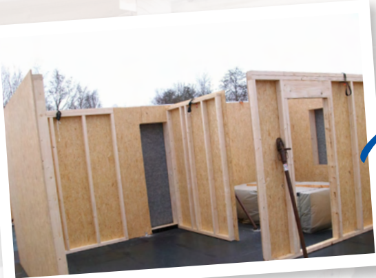
Die Wände werden gerichtet...
