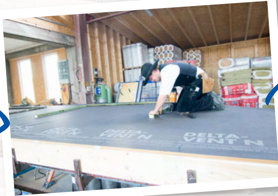
Die Wandelemente sind fertig...
