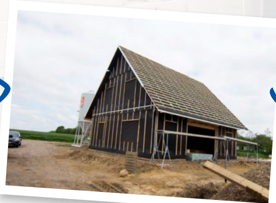
Das Haus ist an nur einem Tag wetterfest aufgestellt...
